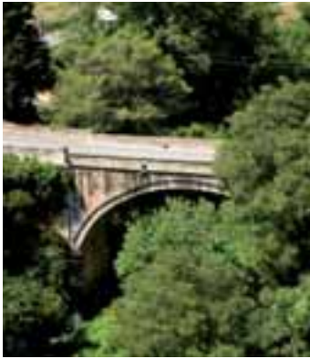
Puente de piedra
